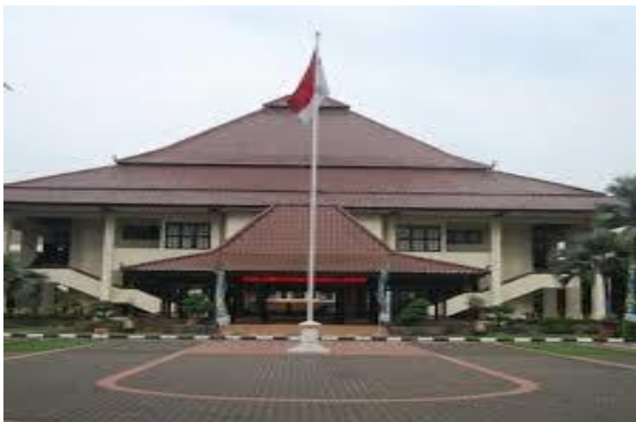
Gambar 4.2. Gedung BPSDM Kemenkumham
